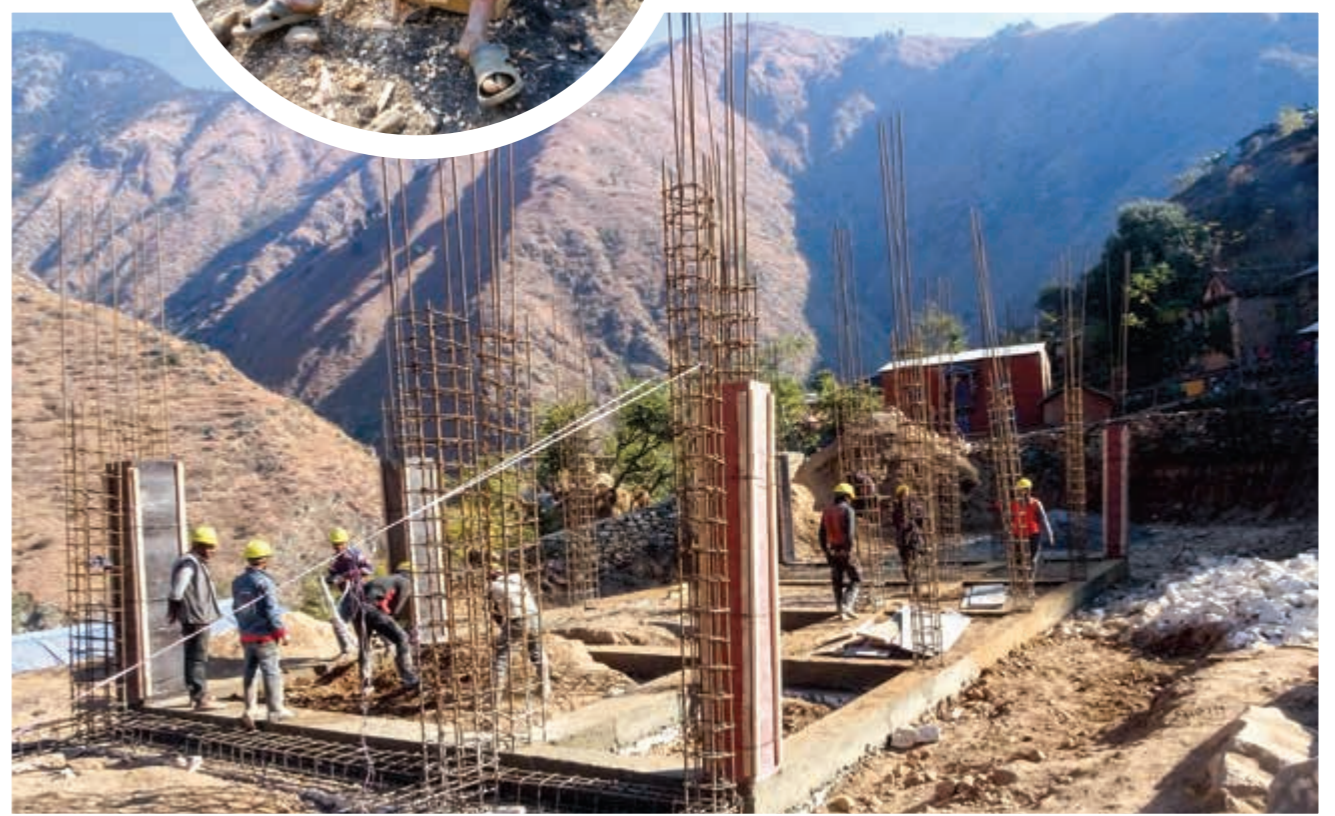
Für die große Schule mit acht Räumen haben wir uns zu einer modernen Stahlbetonbauweise mit Steinmauerwerk entschieden.
