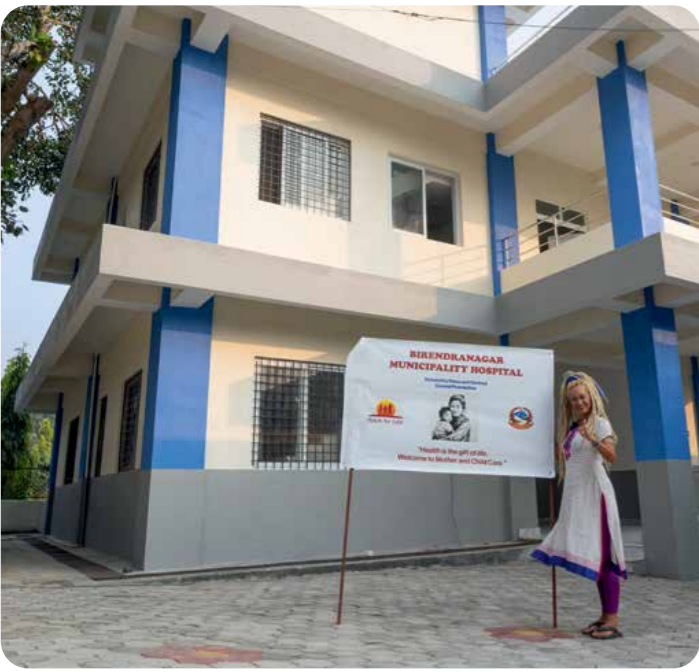
Das Krankenhaus ist nach nationalen Standards erbaut und bietet besondere Erdbebensicherheit.
